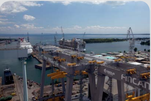
Monfalcone | Fincantieri. Navi in costruzione
